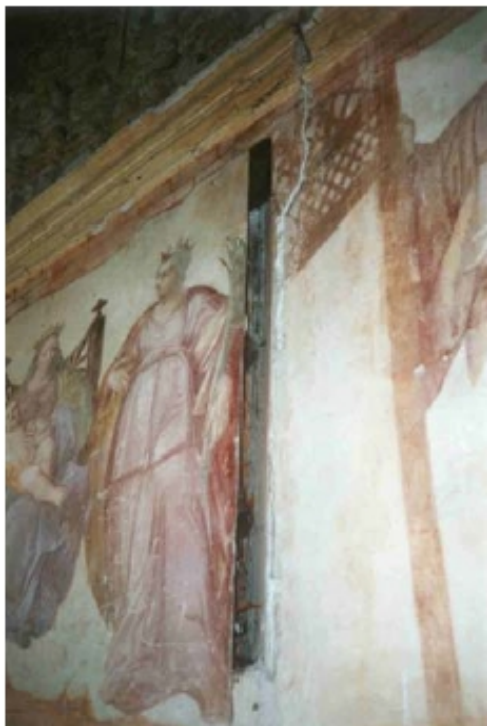
La fente-fenêtre de l'oratoire en restauration. Vue de l'intérieur.
