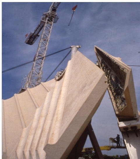
Fig. 11 . La face n° 1 va être clavée à la face n° 2.
