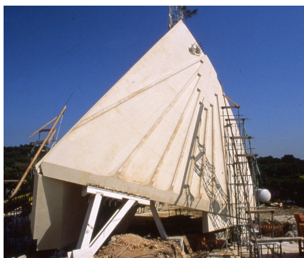
Fig. 13 : Phase de test avec des styles polaires temporaires en bois, orientés sur le méridien du lieu et inclinés de 44° avec le plan horizontal
