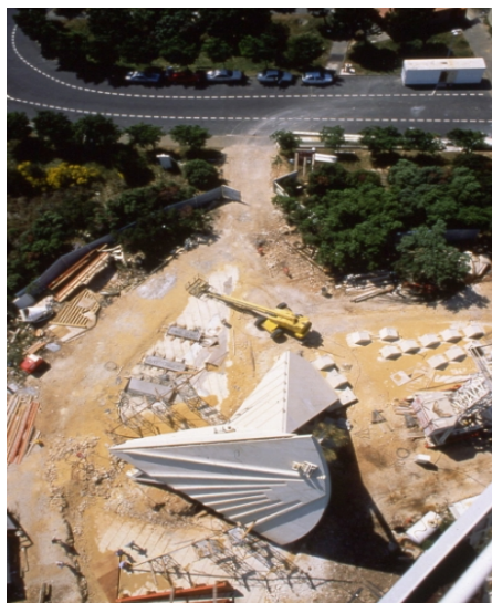
Fig. 12 . Vue de la nef depuis une grue pendant les périodes de test avec le Soleil : ici les trois faces sont éclairées. On attend que la face n° 1 cesse de l'être afin de vérifier que le Soleil quitte son plan au bon moment.
