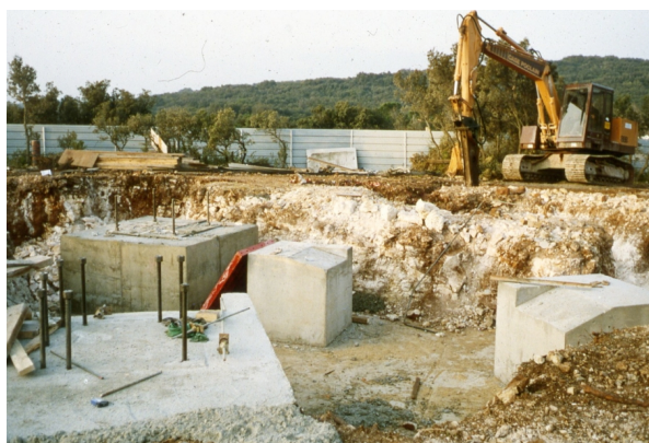
Fig. 7 . Automne 1992 : début du chantier sur l'aire de Tavel ; on voit ici les blocs de béton qui constituent les fondations sur lesquelles vont être fixées les charnières.
