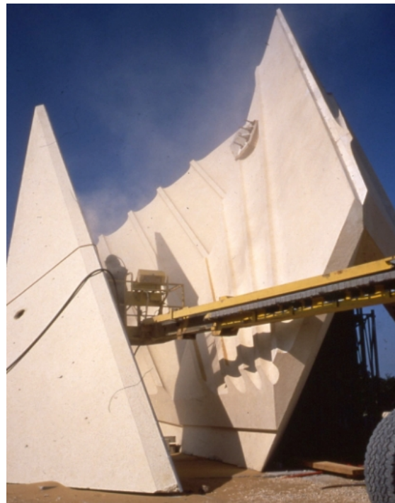
Fig. 17 . On voit ici le coffrage de la dalle de 26 m de diamètre ; toutes les fondations sont immergées dans le béton.
