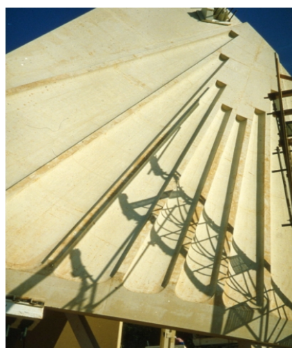
Fig. 14 : On vérifie avec un style polaire temporaire que l'ombre s'aligne parfaitement sur une ligne horaire (ici 7 h solaire)
