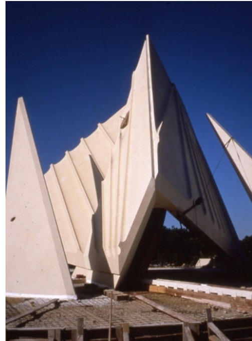
Fig. 17 . On voit ici le coffrage de la dalle de 26 m de diamètre ; toutes les fondations sont immergées dans le béton.
