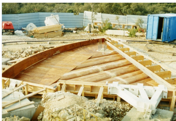
Fig. 8 . Le moule en bois d'une des faces est placé au sol avec ses charnières avant le coulage du béton.
