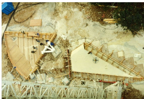
Fig. 9 . Vue depuis une grue des faces n° 1 et n° 2 couchées au sol. La face n° 1 attend son béton blanc.
