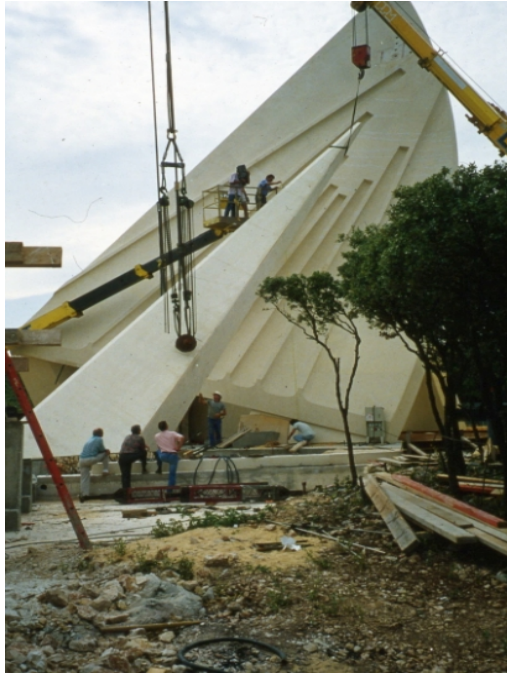
Fig. 16 Opération de scellement du style polaire prismatique du matin.
