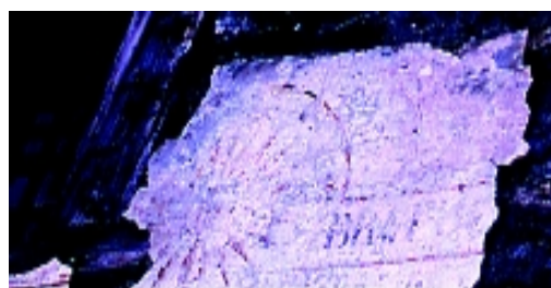
Fig. 10. Une vue partielle du cadran sud-ouest avant restauration [2].
