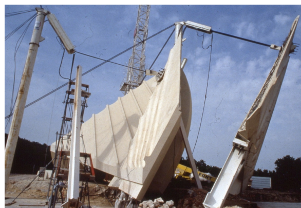
Fig. 10 . Opération de levage de la face n° 1 avec le système de haubans.
